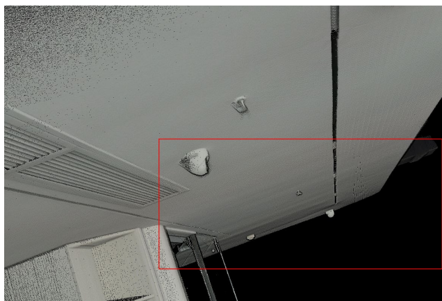
Проверка ровности и правильности установки конструкций
